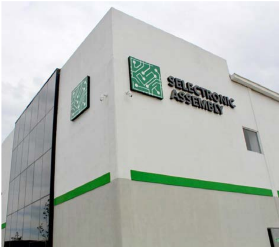
La planta SELECTRONIC ASSEMBLY se dedica a la manufactura de circuitos electrónicos impresos (PCB), empleando tecnología SMT y PTH.
