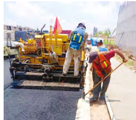
Con la calidad y soporte para tráfico continuo, su empresa desarrolla la colocación de asfalto en vialidades de alta duración.
