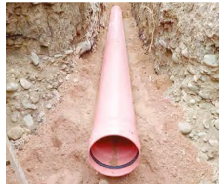
Red de drenaje para grandes obras de infraestructura hidráulica. Construcción del Sanitario San Antonio, en la Isla, Chapala, Jalisco.
