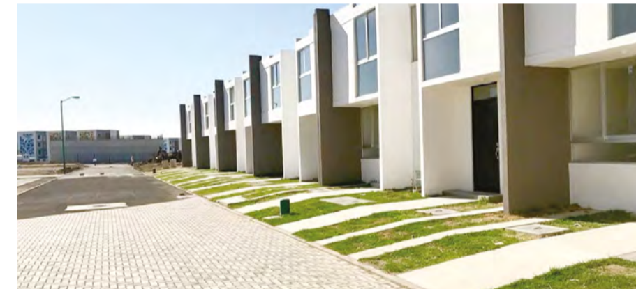
Con su trayectoria en ejecución de proyectos de edificación y urbanización, el ingeniero Michel desarrolla la colocación de adoquín en vialidades del Fraccionamiento Terrasolare, en Tonalá, Jalisco.
