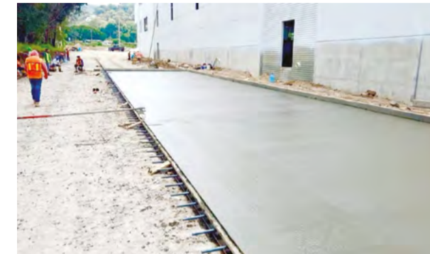
Su empresa URBEDESA garantiza la calidad de cada obra. Aquí, la colocación de concreto en vialidad de nave industrial CCL en Pinar de la Venta, Zapopan, Jalisco.
