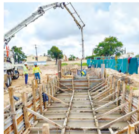
El Ingeniero Berrones Michel, fortalece con su tecnología importantes obras. Aquí, la construcción de una cámara de retención.
