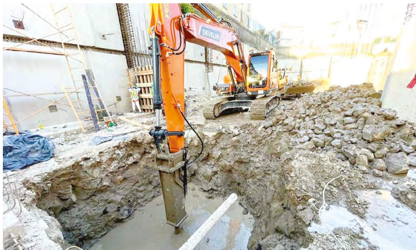
Importantes equipos para la realización de excavaciones en roca para el desarrollo de obras en Tlaquepaque, Jalisco.
