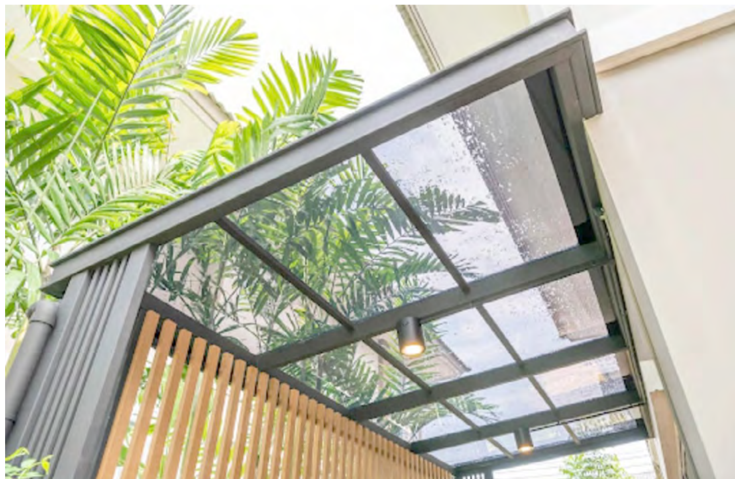
Otro producto destacado de Stabilit es Cubrelit, una lámina translúcida de poliéster reforzada con fibra de vidrio para uso residencial y espacios donde se requiere aplicar cubiertas ligeras.
