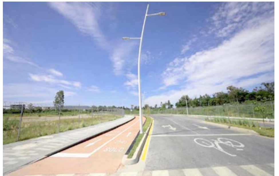
Se realizó la renovación de líneas hidrosanitarias y del canal pluvial, así como pavimentación en concreto hidráulico. También incluyó una ciclovía y la construcción de banquetas con accesibilidad universal y de cruces seguros; la colocación de alumbrado público LED, señalética horizontal y señalética vertical, además de una reforestación endémica.
