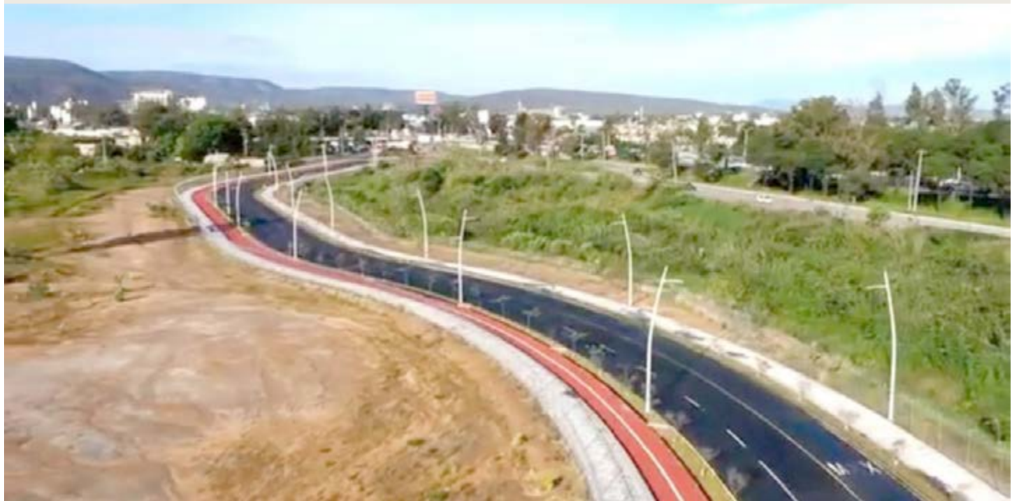
La apertura de esta vialidad beneficiará aproximadamente a más de siete mil 700 personas, la cual se ha convertido en un corredor de la biosfera que conecta con la cuenca de Atemajac y consolidó conexiones con la zona de San Juan de Ocotán y Periférico.
